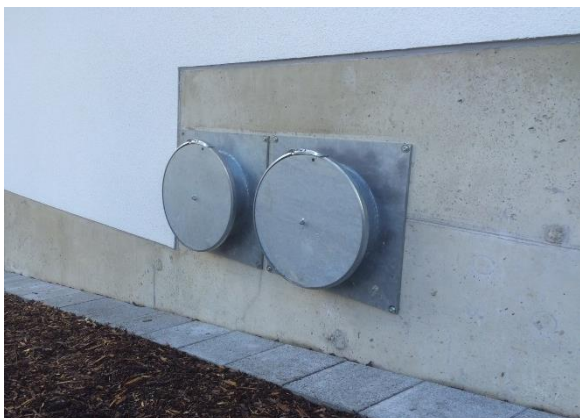
Maan yläpuolinen asennus
